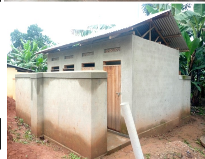
Neu gebaute Grubenlatrine mit acht Plätzen
