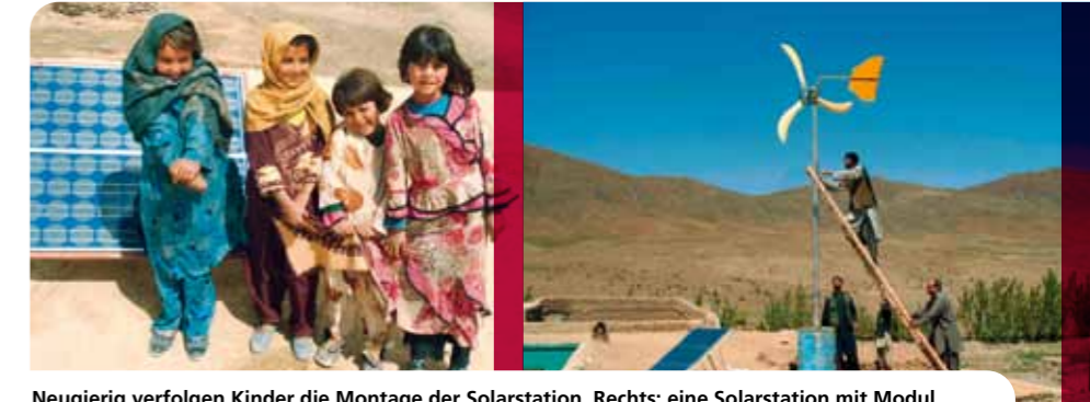
Neugierig verfolgen Kinder die Montage der Solarstation. Rechts: eine Solarstation mit Modul, Windrad und Batterie.
