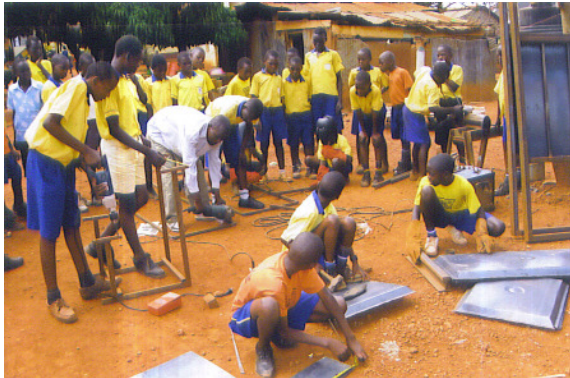
Links: Die Kinder bauen eine Metalltür.
